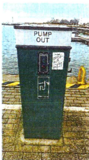
Zdjęcie 3. – Stacja odbioru ścieków
